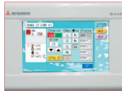
■ Рис. 5. Центральный пульт управления с сенсорным экраном на 144 внутренних блока
