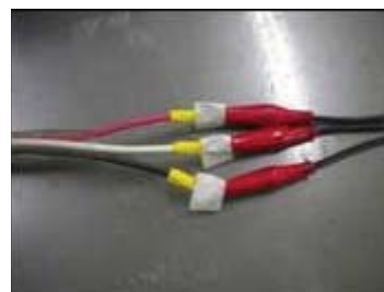
Рис. 2-7 Зажимы, изолированные изоляционной лентой
