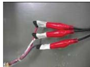
Рис. 2-4 Зажимы, изолированные изоляционной лентой
